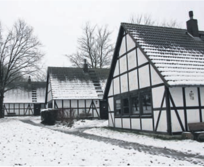
Die Sippenhäuser in der Winterruhe: In den vier Häusern werden die Bäder erneuert. 48 Personen können dort unterge- bracht werden. Die Bettenzahl ändert sich nicht durch den Umbau.
